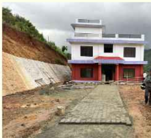
४ नं. वडा कार्यालय भवन, सालु
