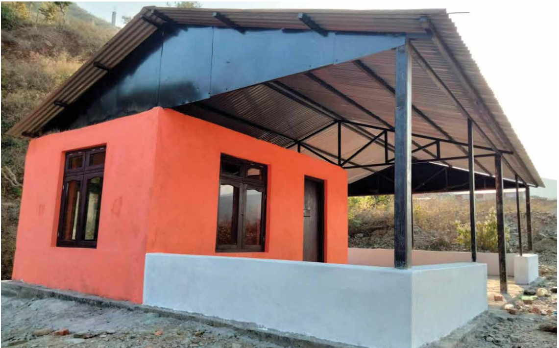
कुनौरी खोप क्लिनिक भवन निर्माण
