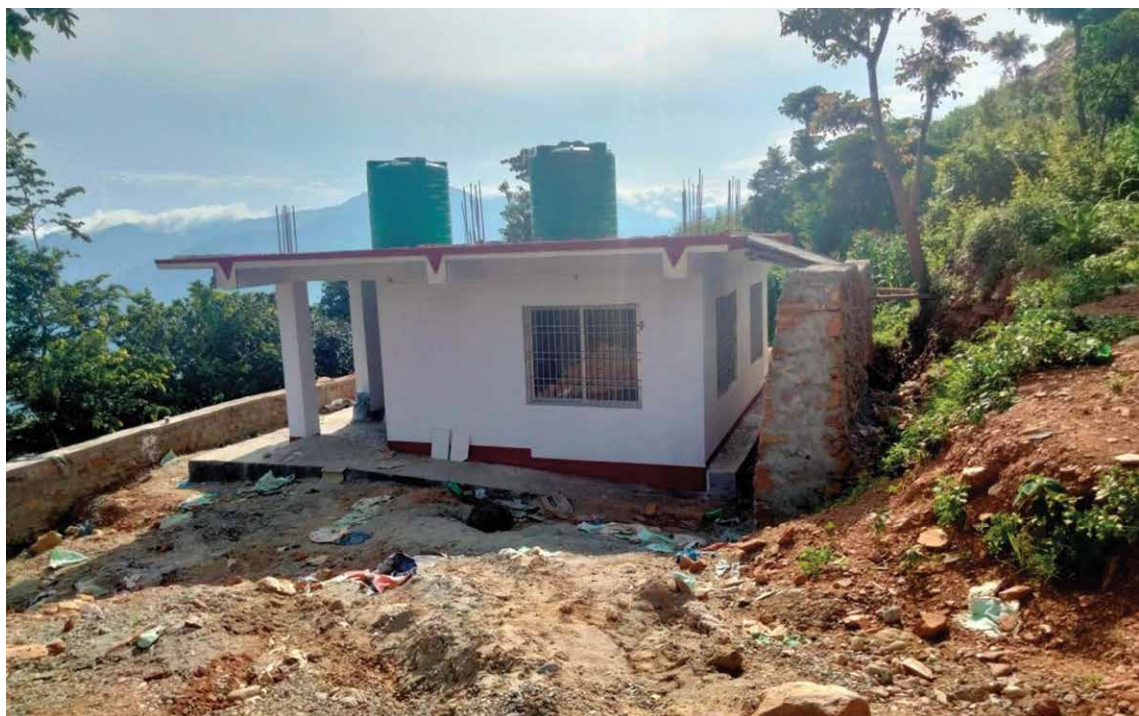
शहरी स्वास्थ्य केन्द्र भवन निर्माण बेतिनी सम्पन्न
