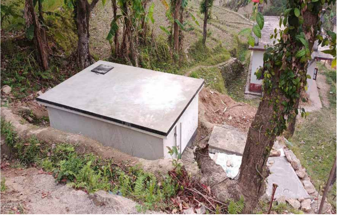
बरबोटे खा.पा.ट्याङ्की निर्माण, म.न.पा.-१३
