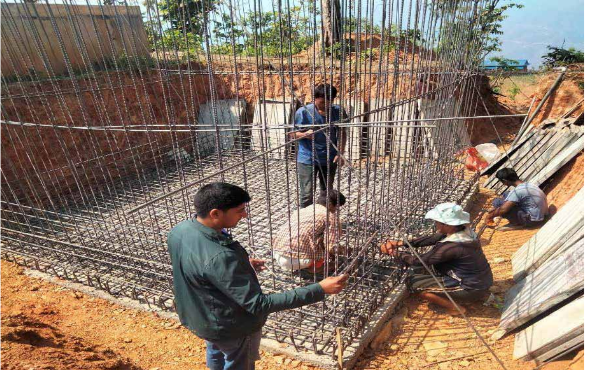
लाम्पाते खा.पा.ट्याङ्की निर्माण हुँदै, म.न.पा.-६
